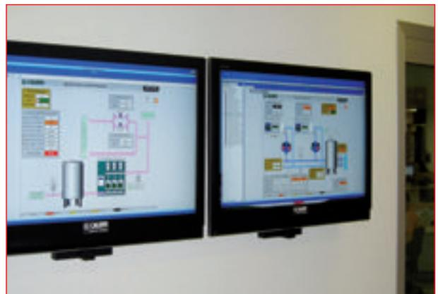
所有的供暖、制冷及生活热水系统均由一套专门开发的软件远程显示和控制。
