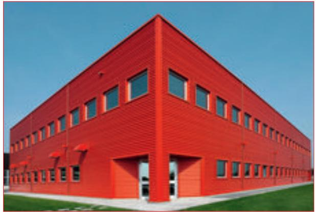
整个建筑年能耗 15.86 kWh/m<sup>2</sup>，归入 A 级节能建筑。这得归功于：非常紧凑的建筑结构，高热阻系数的门、窗及墙面材料，以及可替代能源的运用。
