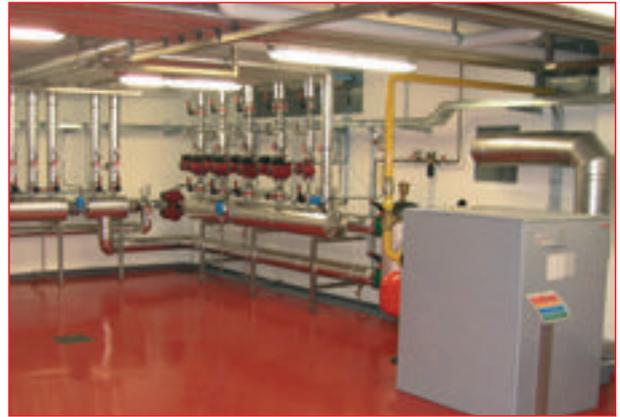
供暖主机为一台450 kW冷凝式锅炉，它可根据热需求分5级供暖。
