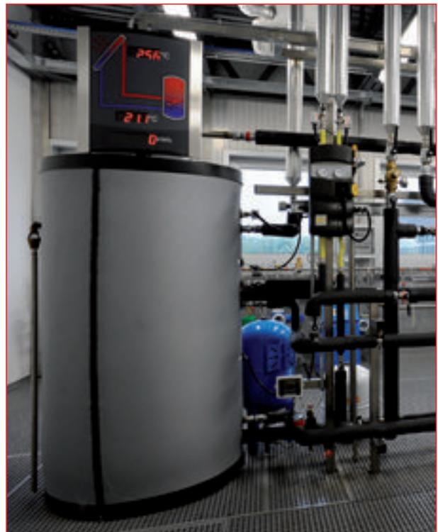
研发中心的供暖、制冷及生活冷热水系统不仅服务于大楼的办公环境，同时还为实验室提供其实验用水所需的流量、压力和温度。
