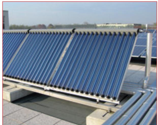
同时，红立方屋顶还铺设了 140m<sup>2</sup> 光伏集热板，太阳能光伏系统用于提供部分办公用电。
