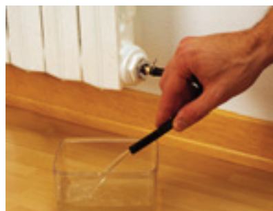
3 水平拉动泄水软管即打开泄水阀将散热器管内部的水放到相应的盆里。
