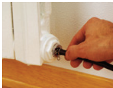
2 将泄水软管拧到泄水阀上
