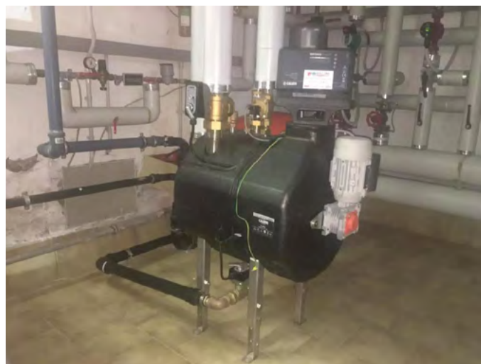
除污机现场安装图
